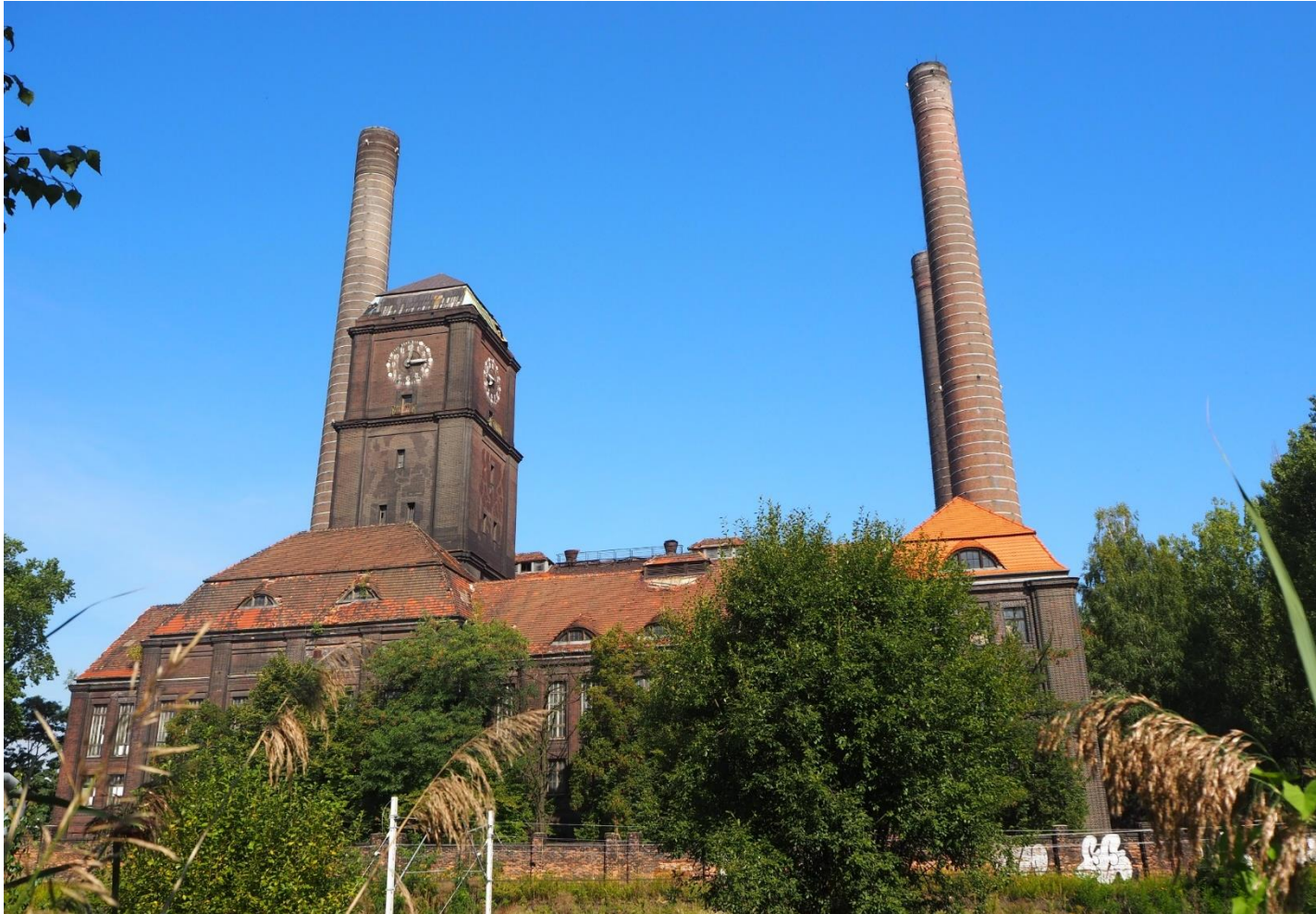
Elektrociepłownia „Szombierki” w Bytomiu (fot. J. Koj)
