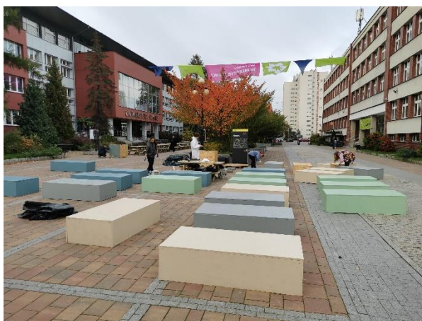
Zdjęcia nr 3 i 4. Budowa tymczasowych mebli miejskich z palet, kantówek i płyt OSB – w ramach projektu Laboratorium Rawa w Katowicach (2022 rok), fot. Paweł Jaworski
