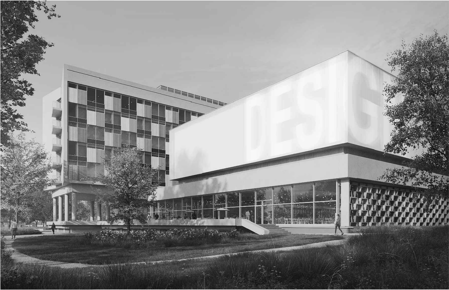
widok na dawny pawilon restauracyjny z nadbudową - magazynem sztuki
